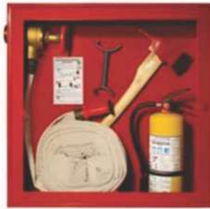
GABINETE CONTRA INCENDIO
